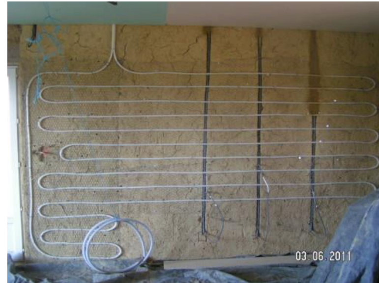
MUR CHAUFFANT BASSE TEMPERATURE:
