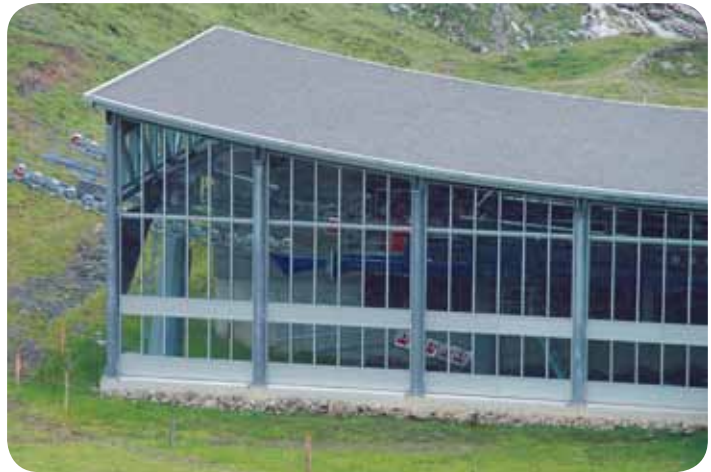
Station de télécabine à trois côtés vitrés. Lors d'un retour tardif de la neige, les oiseaux se sont réfugiés dans le bâtiment et sont entrés en collision avec le verre souvent depuis l'intérieur.
