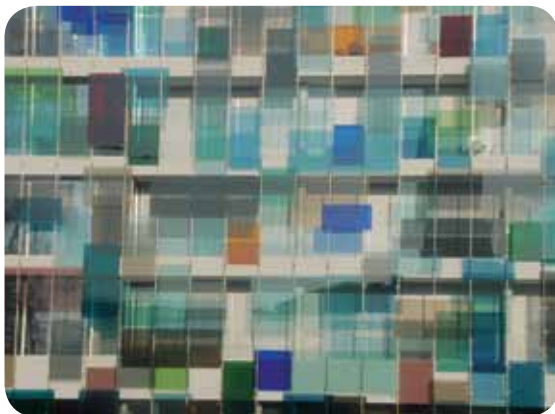
En raison des différentes profondeurs et des divers coloris, cette façade devient visible comme obstacle.
