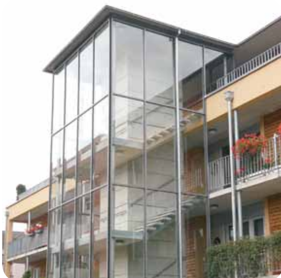
Cage d'escalier en verre
