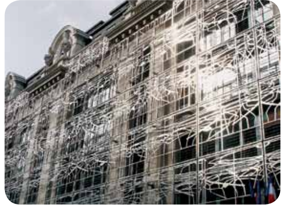
Structure grillagée au ministère de la culture à Paris : art architectural et protection des oiseaux.
