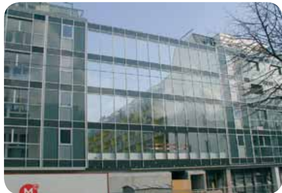
Paroi antibruit et coupe-vent entre deux bâtiments
