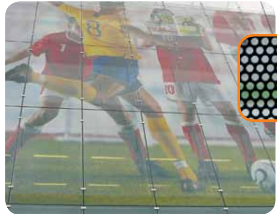
On peut couvrir des façades entières avec de grands films publicitaires. Ils sont en général perforés et permettent donc dans une certaine mesure de voir à travers.
