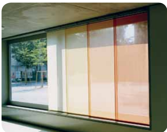
Jeux de couleurs avec des rideaux de différentes teintes. Mais plus le degré de réflexion de la façade est grand, moins des rideaux fixés à l'intérieur sont efficaces.
