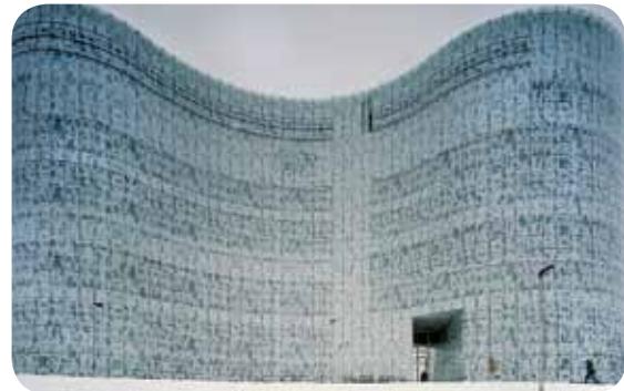
Bâtiment de l'Université technique de Cottbus, Brandenbourg. Les impressions couvrent la totalité de la surface.
