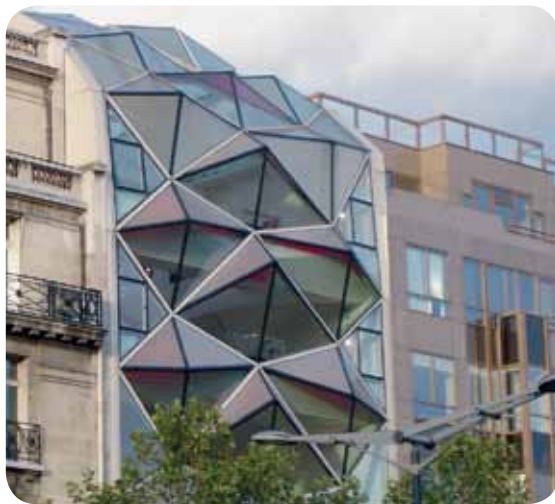
Nouvelle interprétation efficace d'une façade en verre.
