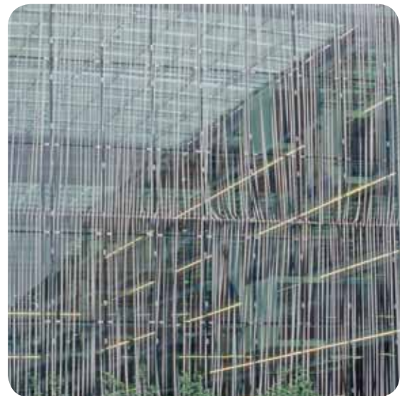
Des bandes en plastique claires ont été fixées devant ce bâtiment comme solution de secours.
