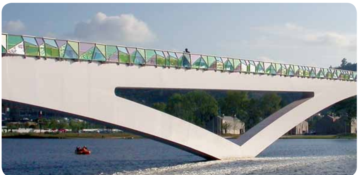
Cette passerelle pour piétons à Coimbra/Portugal amène de la couleur dans le paysage.
