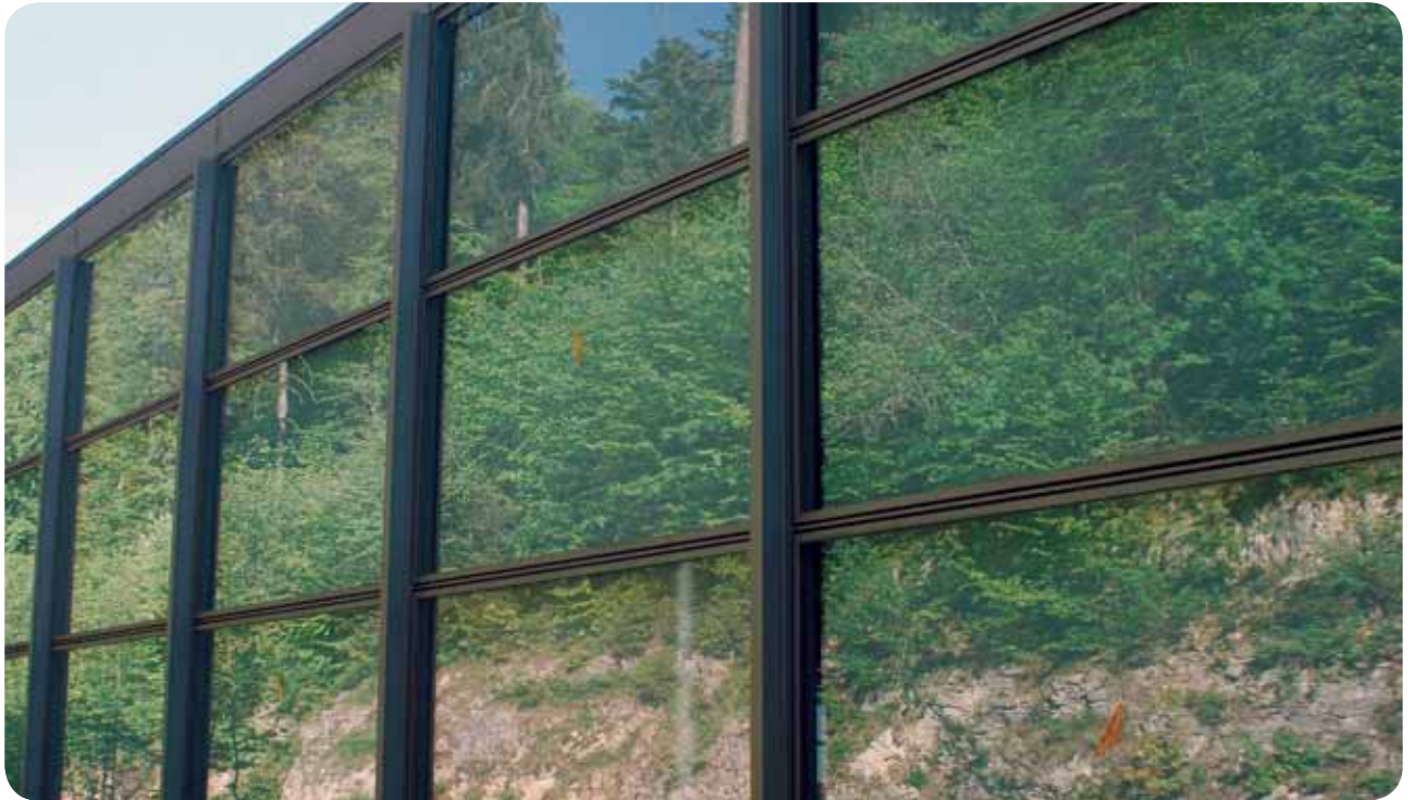
Un gymnase ayant un côté parallèle à la lisière de la forêt. Il n'y a ici aucune raison impérative d'installer des verres à haut degré de réflexion sur ce côté exposé à l'ouest.
