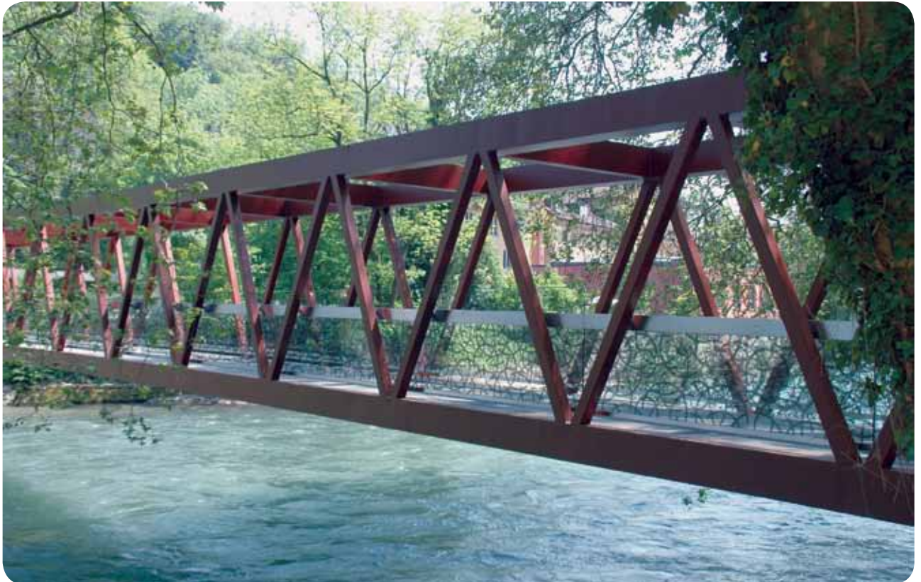
Les ponts qui traversent un cours d'eau à faible hauteur tels que celui-ci se situent souvent en travers des corridors de vol des oiseaux. Dans ce cas, on a tenu compte de la protection des oiseaux lors de la planification.
