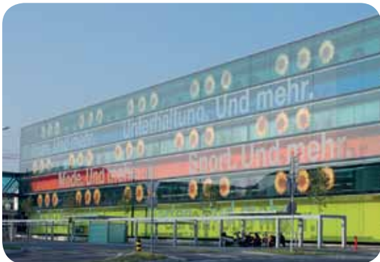
Centre commercial aux accents colorés. Un verre à faible taux de réflexion a été utilisé.
