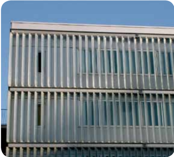
Des lamelles verticales ou horizontales produisent une ombre et divisent la façade. Les oiseaux voient qu'il s'agit d'un obstacle.
