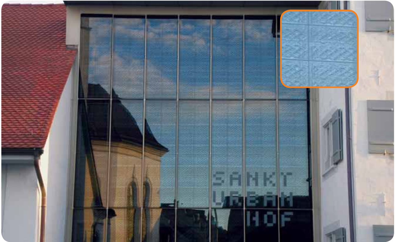
Nouvelle aile qui relie deux bâtiments historiques. Ce type de verre est fortement réfléchissant, mais la surface est rendue visible par la trame qui la recouvre et par l'inscription.
