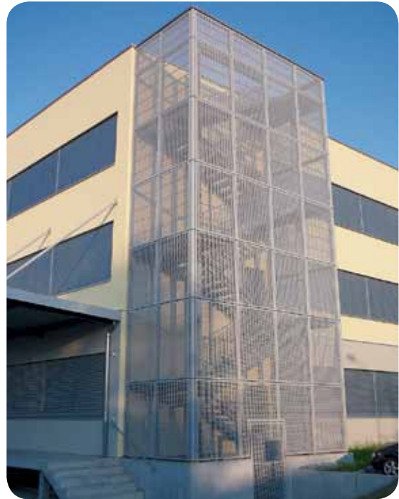
Treillis métallique : laisse passer la lumière, économique et sans danger pour les oiseaux.
