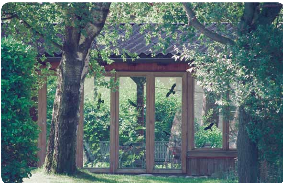
Un petit coin douillet dans la verdure. Les haies produisent un effet corridor supplémentaire qui mène les oiseaux droit sur la vitre. Les silhouettes de rapaces confirment que les propriétaires sont conscients du problème. Mais elles ne le résolvent certainement pas.
