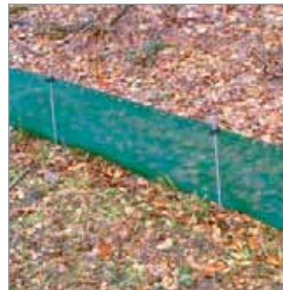
▲ Clôture de protection pour amphibiens
