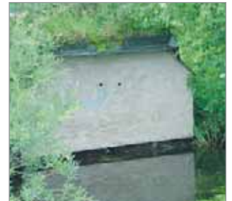
▲ talus de rive artificiel
