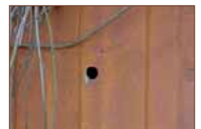
▲ derrière un revêtement en bois
