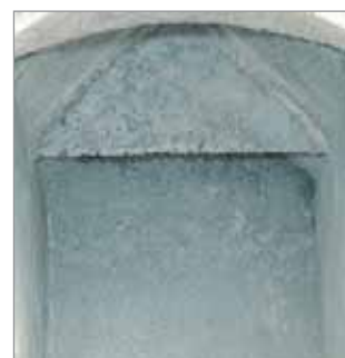
▲ angle de retrait à l'intérieur du toit
