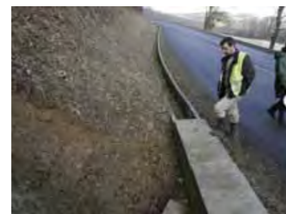
>> Le plus grand passage à petite faune d'Europe réalisé sous une route départementale à la réserve naturelle du Grand Lemps.
