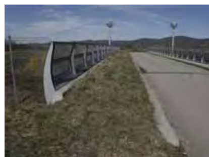
>> Trottoir végétalisé sur un pont pour favoriser le passage de la faune.
