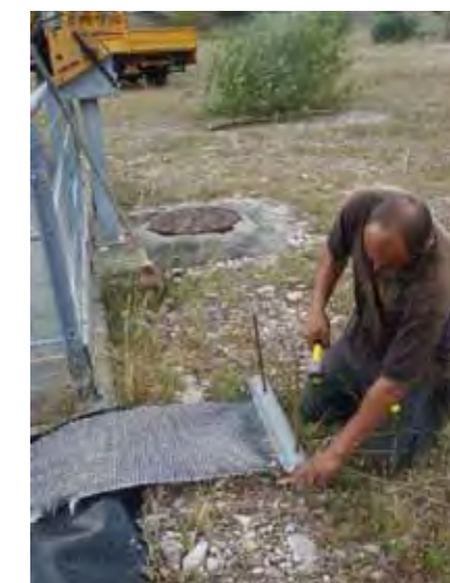
>> Mise en place échappatoires avec système d'accroche coulé dans du béton.
