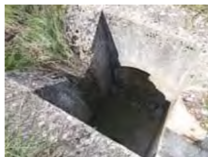
>> Fosse d'écoulement des eaux pluviales sous voirie dont une paroi pourrait être aménagée en pente douce.
