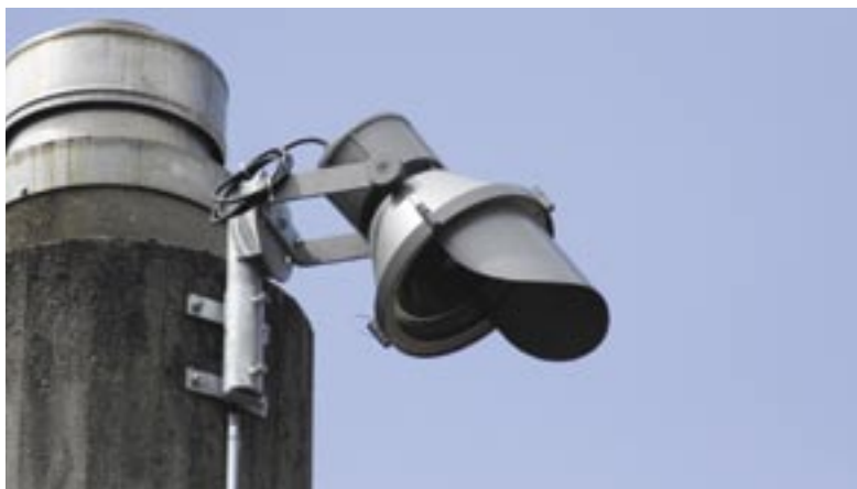
L'orientation n'est pas idéale, mais elle est acceptable en raison du volet dont a été munie la lampe.
