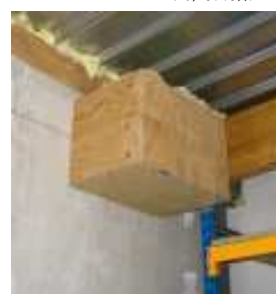
effraie des clochers accès à un nichoir apposé dans un local technique
