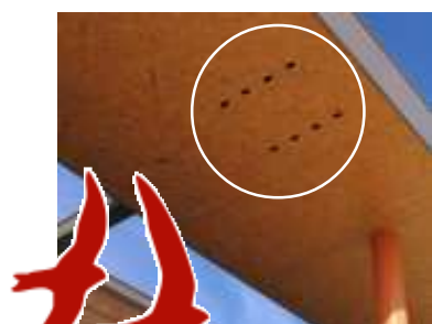
martinets noirs 24 entrées sous le toit vers des caissons nichoirs
