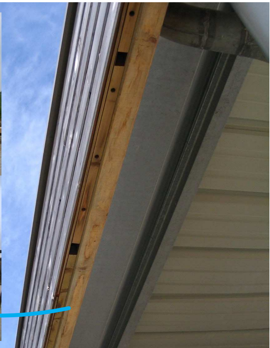
Trous d'accès à l'espaces situé derrière le bardage pour les chauves-souris
