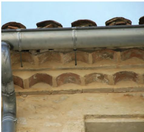
La couverture sera réalisée en tuiles de terre cuite de type traditionnel, dites « demi-ronde », « creuse » ou « canal ». La couleur sera proche des nuances de la nappe des couvertures existantes dans le Secteur Sauvegardé, de teinte claire et uniforme. Les solins seront réalisés en plomb ou en zinc.
