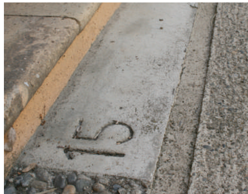
Traitement des seuils avec adresse gravée - Grisolles (82)
