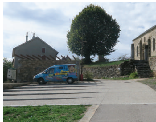
Placette traversante en béton sablé (Chalier-15)
