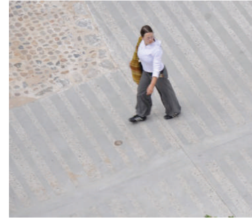
Pochoir en bande sur béton sablé
