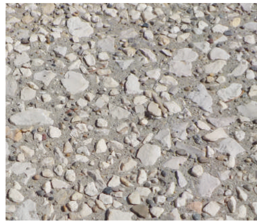
Exemple de mise en oeuvre de béton désactivé à partir d'agrégats locaux réalisation de béton désactivé et de bande béton lisse avec Granulat 6/16+16/22 SCV + sable de Bellegarde + ciment gris
