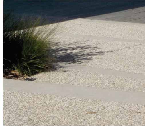
Exemple de mise en oeuvre de béton désactivé à partir d'agrégats locaux réalisation de béton désactivé et de bande béton lisse avec Granulat 6/16+16/22 SCV + sable de Bellegarde + ciment gris
