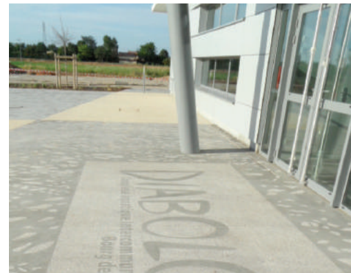
Traitement du seuil d'entrée d'un équipement avec inscription au pochoir du logo de l'équipement
