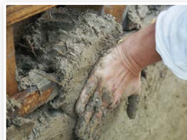
On serre avec la main les torches sur celles du bas. Aucun risque, le torchis n'est pas nocif. Au contraire, son taux d'argile le rend particulièrement bon pour la peau !
