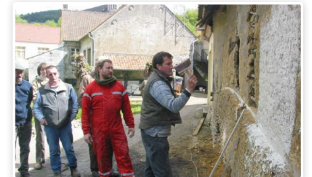
Pose de badigeon à la brosse
