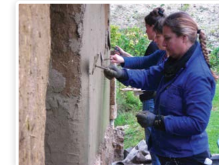
On pose l'enduit à la truelle, puis on le serre
