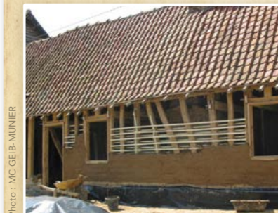
Charpente d'un mur gouttereau
