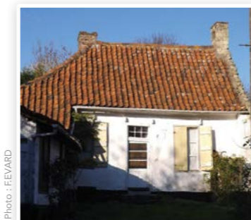
Guémy, pignon débordant maçonné
