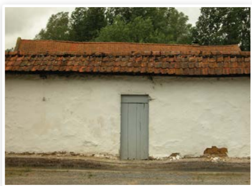
Merck-Saint-Liévin, un mur de clôture
