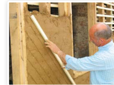
On strie le torchis existant pour faciliter l'accroche de l'enduit
