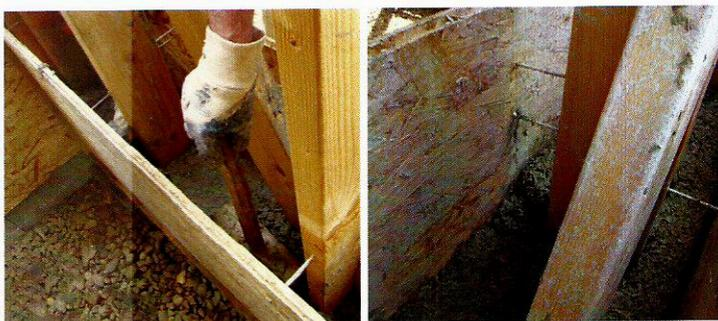
25 cm, alors la 1<sup>re</sup> hauteur de banches pourra être enlevée par glissement latéral (le temps pendant lequel le mortier devra rester entre banches ne pourra être inférieur à 20 minutes).
