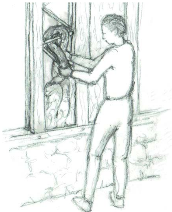
Illustration 32. Pose tressée : Soit les pailles sont imprégnées dans une barbotine puis torsadées, elle formes alors une La longue torche de torchis à l'état plastique est tressée sur le support. Soit elles sont réalisées avec une corde de paille sèche, la pose se réalise tressée sur le support. Finition d'égalisation ou de remplissage avec un enduit de torchis plaqué.
