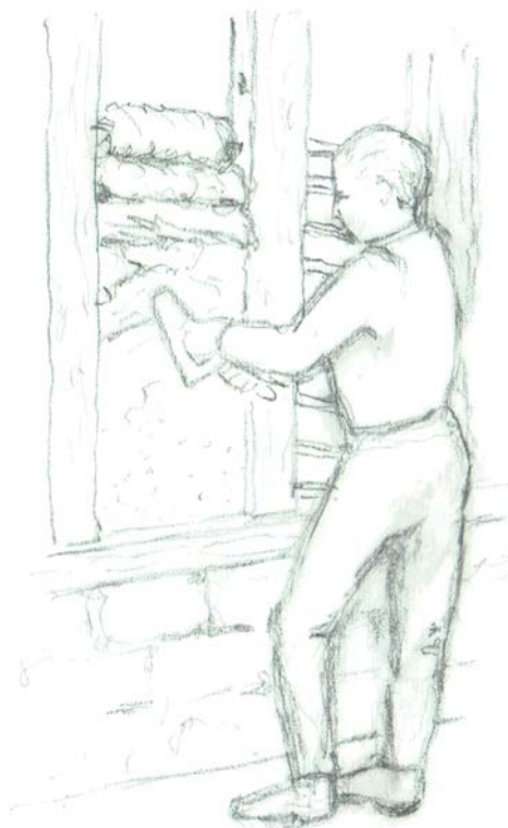
Illustration 31: Finition d'égalisation après pose à cheval ou pose en fusées.
