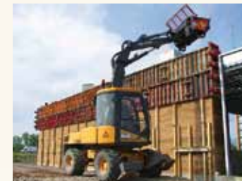
Coffrage en métal de type béton et godet malaxeur.
