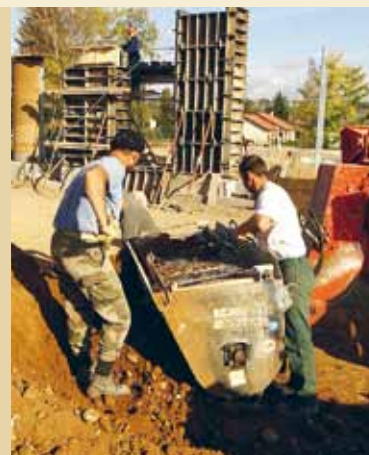
Mise en oeuvre de la terre à l'aide d'un godet malaxeur.
