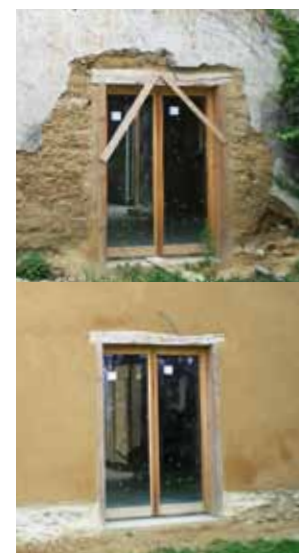
Avant et après reprise de l'enduit
