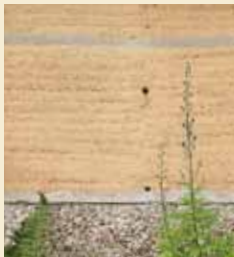
Textures de pisé ancien, rénové et contemporain.
