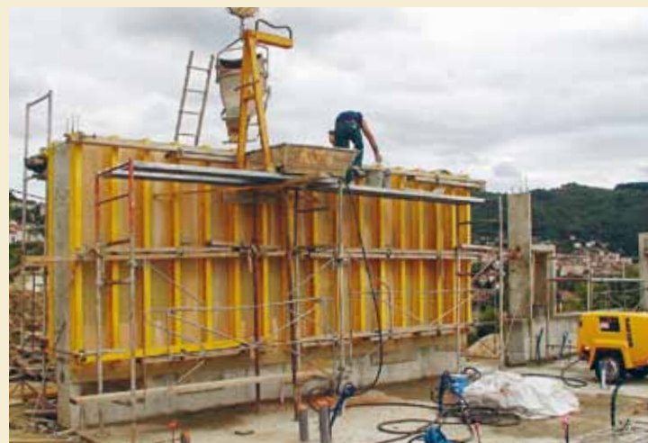
En haut à droite Manutention d'une banchée préfabriquée pour un chantier à Montbrison.
