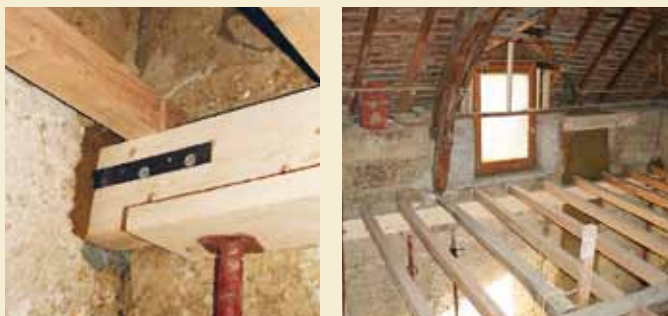
Proposition 2 : Des ouvertures verticales sur toute la hauteur du mur sont possibles, elles seront de préférence réalisées en continuité de l'existant. Des parties de mur en pisé très dégradées (fissure, ravine, effondrement) peuvent être également un endroit privilégié pour réaliser ce type d'intervention
