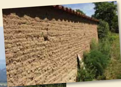
Les murs de clôture en pisé sont un élément fort du paysage du Parc.
