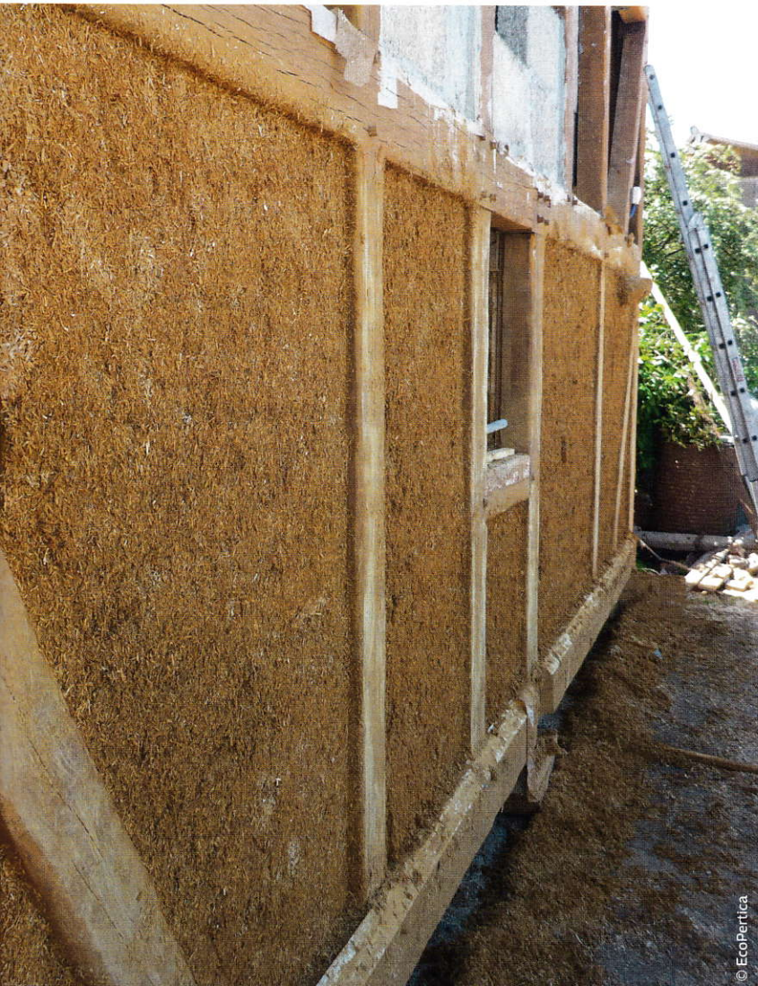
Réfection d'un colombage par projection de chanvre-terre argileuse locale.
