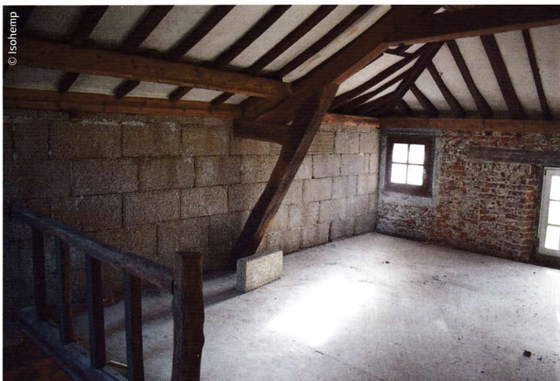
Contre-cloison d'un mur pierre en briques de chanvre.
