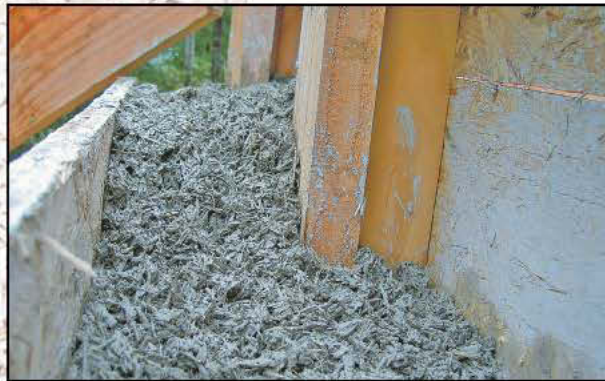
Vue du remplissage d'un mur banché
