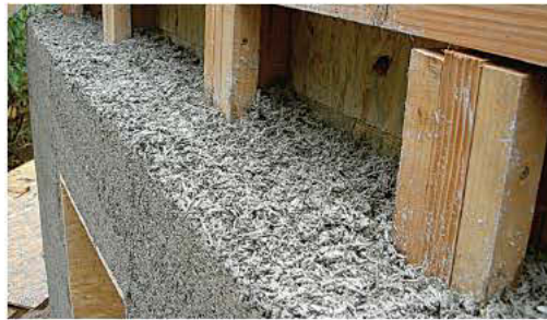
Exemple banché Chaux/Chanvre
