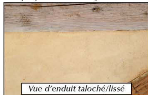
Vu d'un remplissage en colombage
