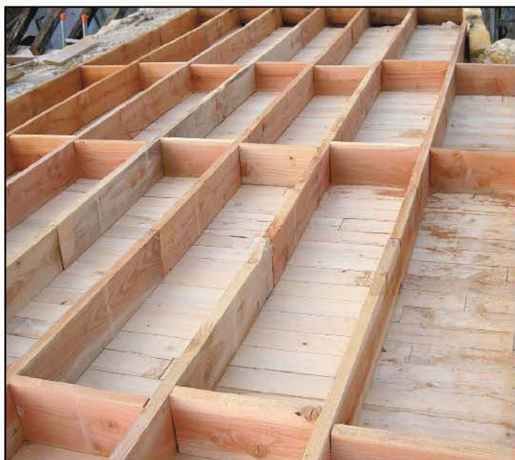
Vue d'un coffrage avant remplissage
