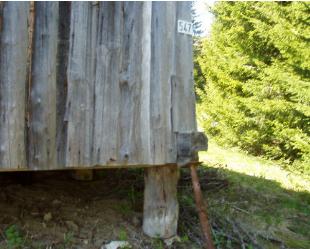
Fondations piliers bois
