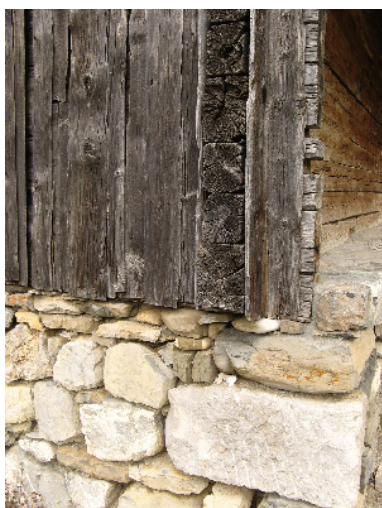
Interface entre le soubassement pierre et la ruche
