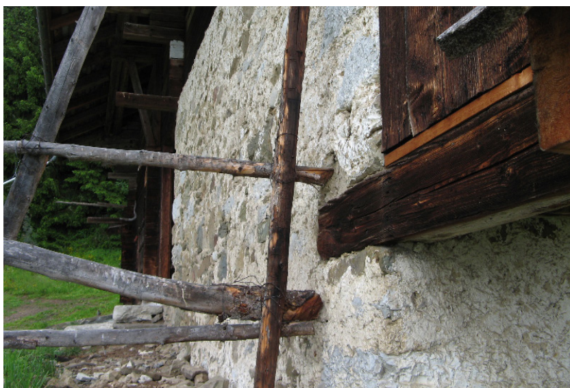
Appareil du mur lié à la chaux
