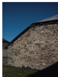
Enduit à la chaux et sable
