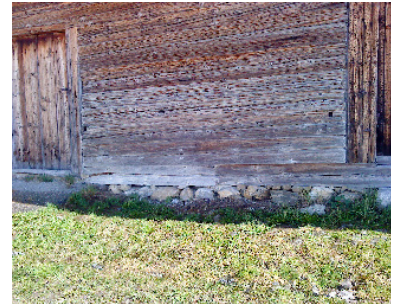
Soubassement en lit de pierres
