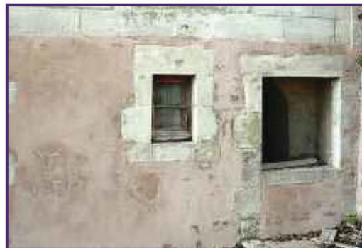
Support avant application du SANIMUR®
