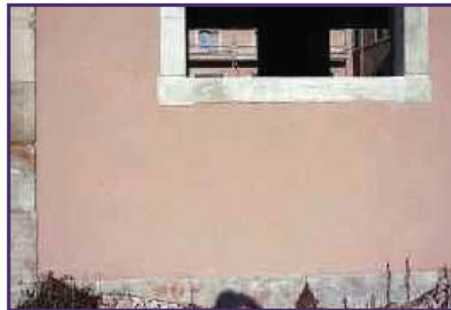
Support réalisé avec SANIMUR®
