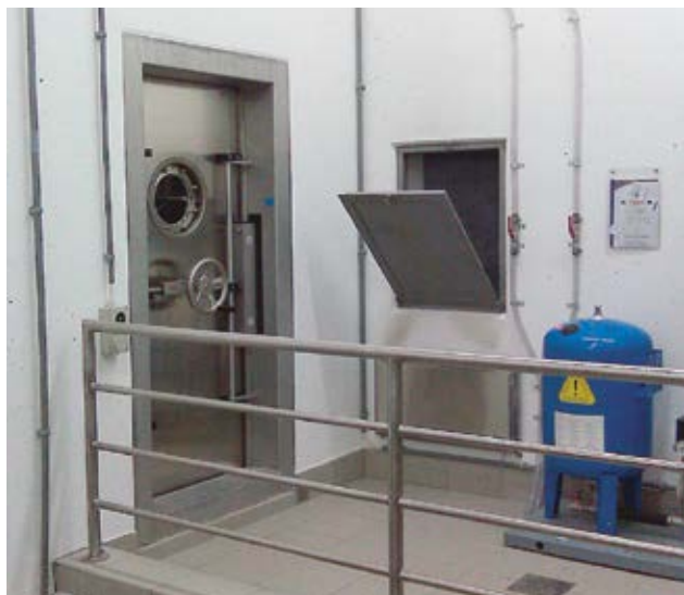
Fig. 6 et 7 les locaux présentant des concentrations élevées de radon sont fermés de façon étanche.
