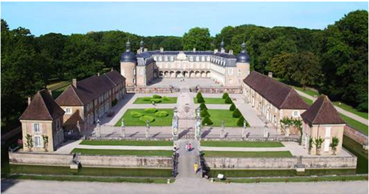
Dépendance Sud du château de Pierre-de-Bresse (1991)
