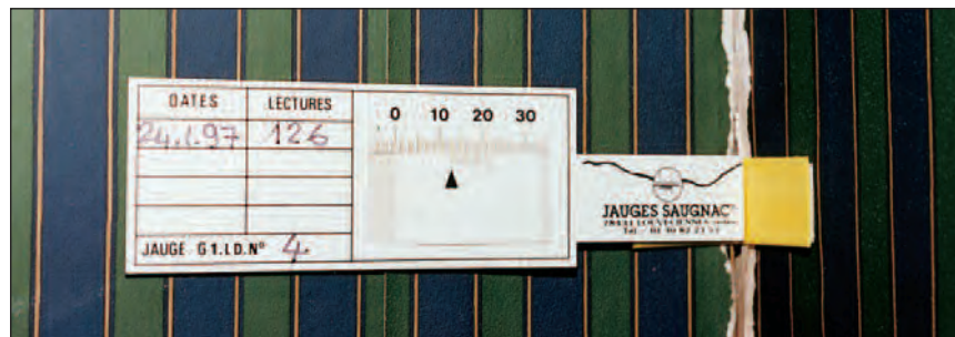
La cueillie fait un angle à 90°. Pose d'une jauge G1 avec cornière plastique
