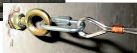
Accrochage et tension du dispositif G130
